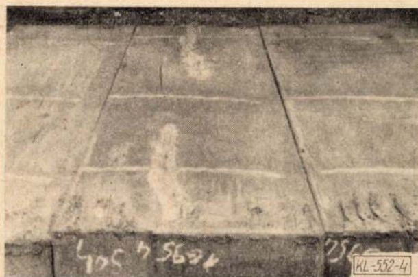
4. ábra. Felület alatti hibák feltárása szalagozással, folyamatosan öntött szálak felületi tisztítása előtt
