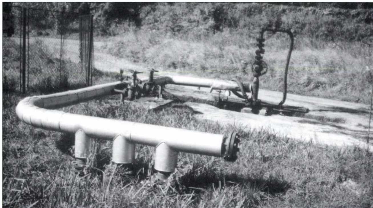
5. kép: GELLÉNHÁZA (Zala megye) NL-403 jelű, rétegvíz-likvidáló; visszasajtoló kút (Nagylengyeli olajmező)
