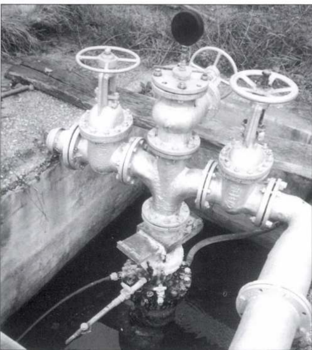
2. kép: CSORNA (Győr-Moson-Sopron megye) K-47/K 707647 azonosító jelű kút, kifolyó-hőmérséklet: 69 °C, komplex hasznosítás
