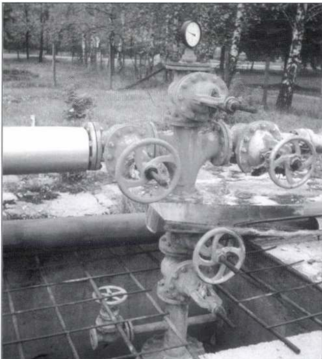
1. kép: LIPÓT (Győr-Moson-Sopron megye) I. sz. (K-7) K 70147 azonosító jelű kút, kifolyó-hőmérséklet: 64 °C, komplex hasznosítás
