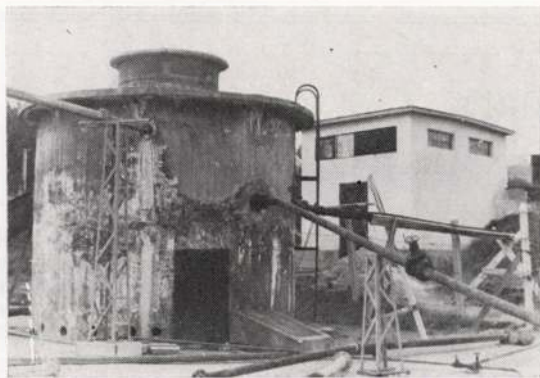
3. kép Gázleválasztó a két termelőkút részére
