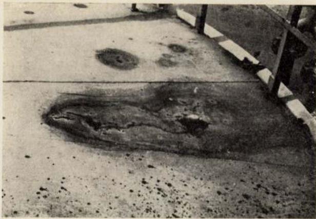
4. ábra Sztiaszerűen átlukadt tető benzintároló tartályon
