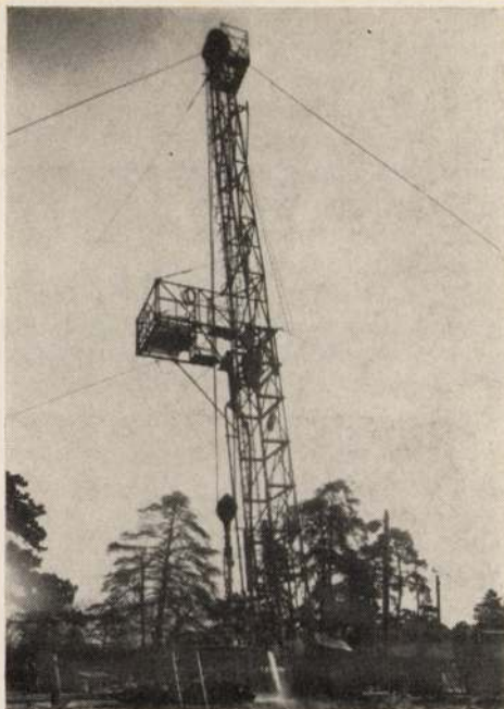
3. ábra PK—21—40/7 típusú lyukbefejező berendezés
