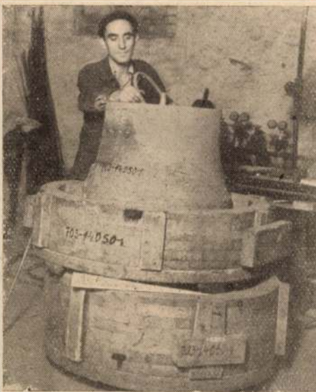
6. ábra. Nagy nyersszilárdságot megkövetelő mag készítése
