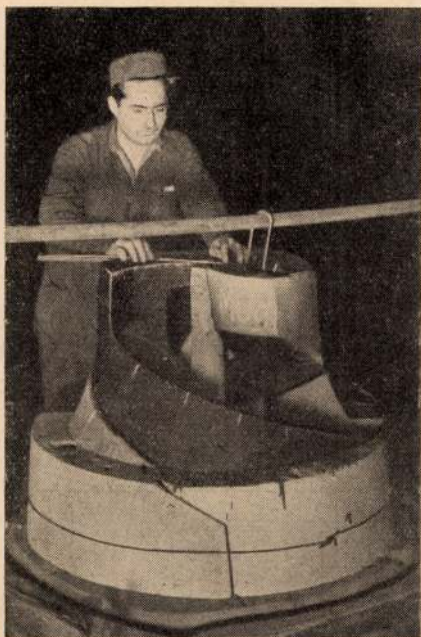
19. ábra. A 18. ábrán bemutatott öntvény formájának összerakása
