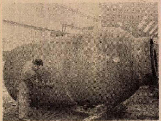
13. ábra. Lúgbepárló tartály felsőrész
