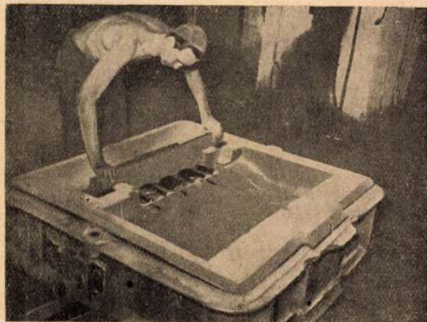
5. ábra. A megmunkálás kiindulási pontjának ellenőrzése. (vezértengelyfurat a mellő-alsó magban).
