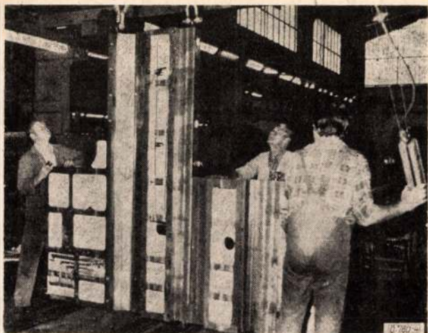
4. ábra. A megmunkálóközpont ágyszánja GB/GC300 minőségű Meehanite-öntöttvasból. Mérete 2500×2200×360 mm
