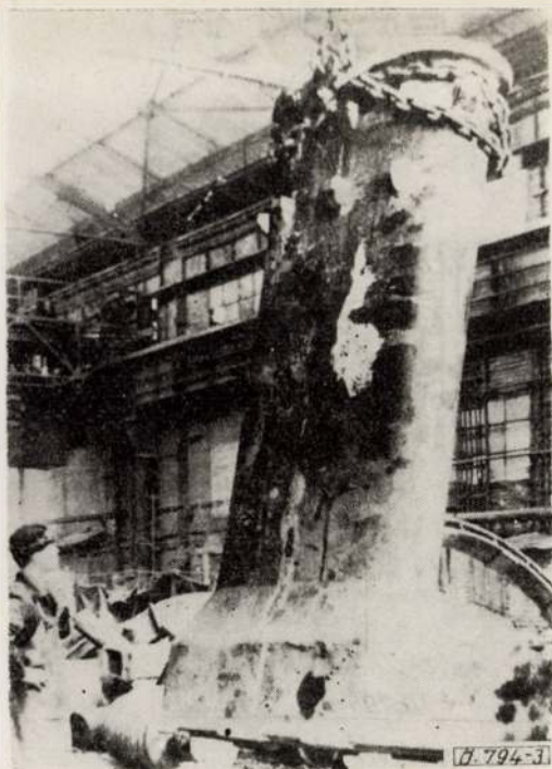
3. ábra. A Péti Nitrogénművek részére öntött szénkénegetretorta
