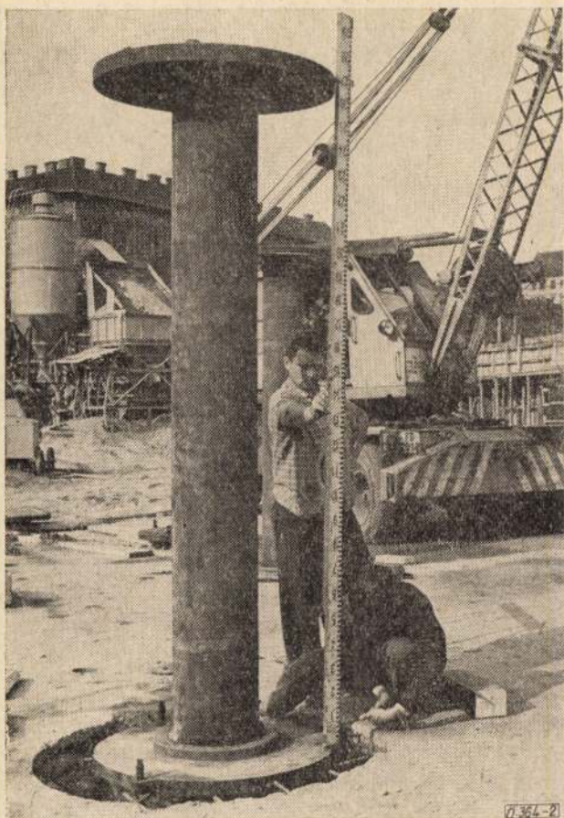
2. ábra. Oszlopok szerelése a Baross téri aluljáróban, 1968-ban
