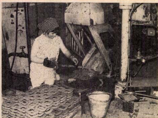
2. ábra. Fitting-mag készítése önműködő magkészítő géppel
