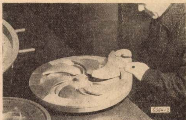
2. ábra. Héjmag készítéshez gyártott alumínium mag szekrény magkönyvtő betétekkel
