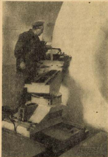
2. ábra. Nagy borovi fenyőkorong síkesztergálása
