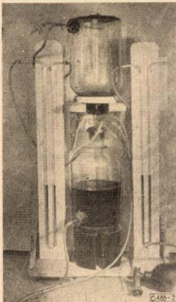
2. ábra. Az új nyomásos öntési elv modellje
