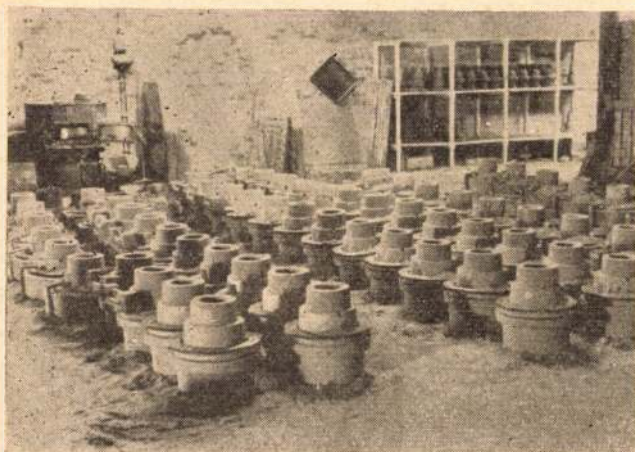
21. ábra. Öntésre előkészített szekrény nélküli héjformák 25 kg-os kerékagy acélöntvények részére
