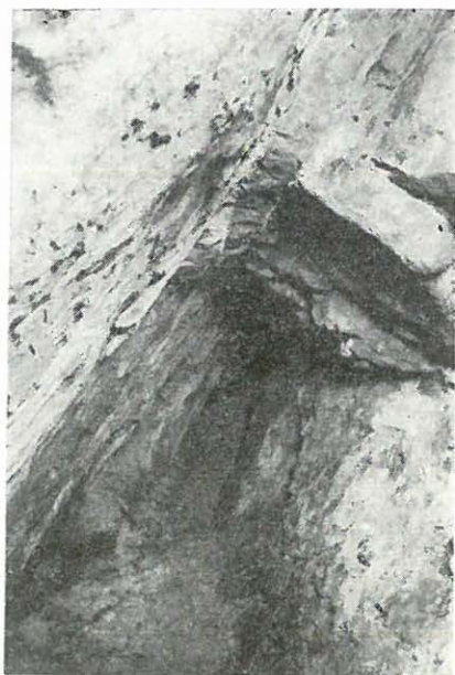
36. ábra. Középkori kutatóvágat galenites zsinór mentén, Felső Fagyosasszonybánya Figure 36. Mediaeval exploring drift along a galena stringer, Felső Fagyosasszony-gallery
