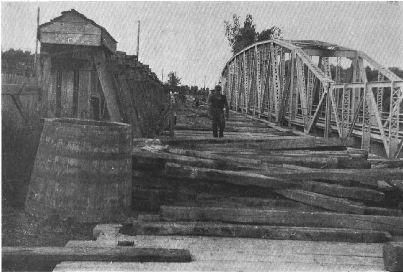
15. A fahíd bontása előtt ideiglenes közúti híd épül
