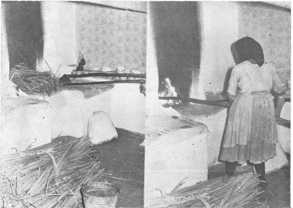
Heizung im Bauernofen von der Küche her
