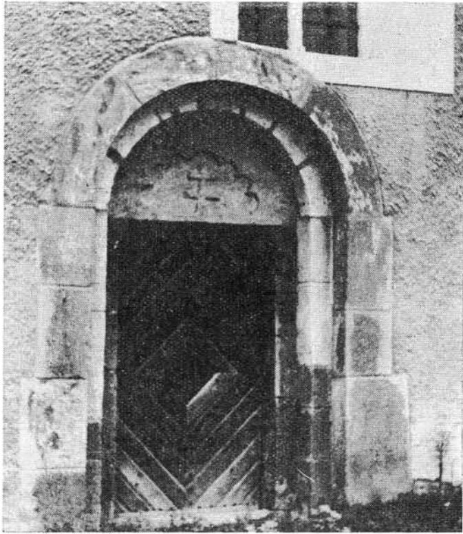
9. kép. A bodrogszerdahelyi (Streda nad Bodrogom) templom déli kapuja.
