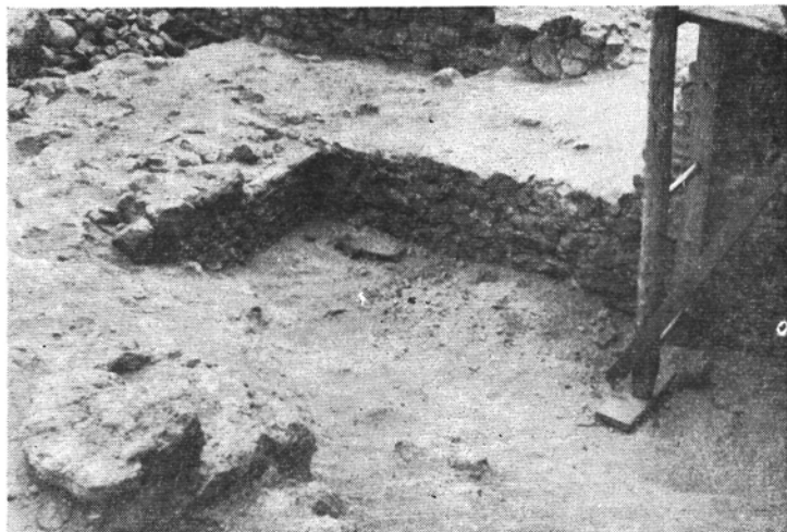
38. kép. Az öregtorony előkerült alapozása felülről.
