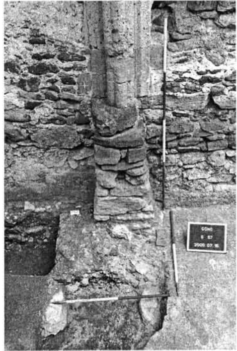
10. kép. Az s57-sz. oltáralap és a kapcsolódó falpillér alsó szakasza
