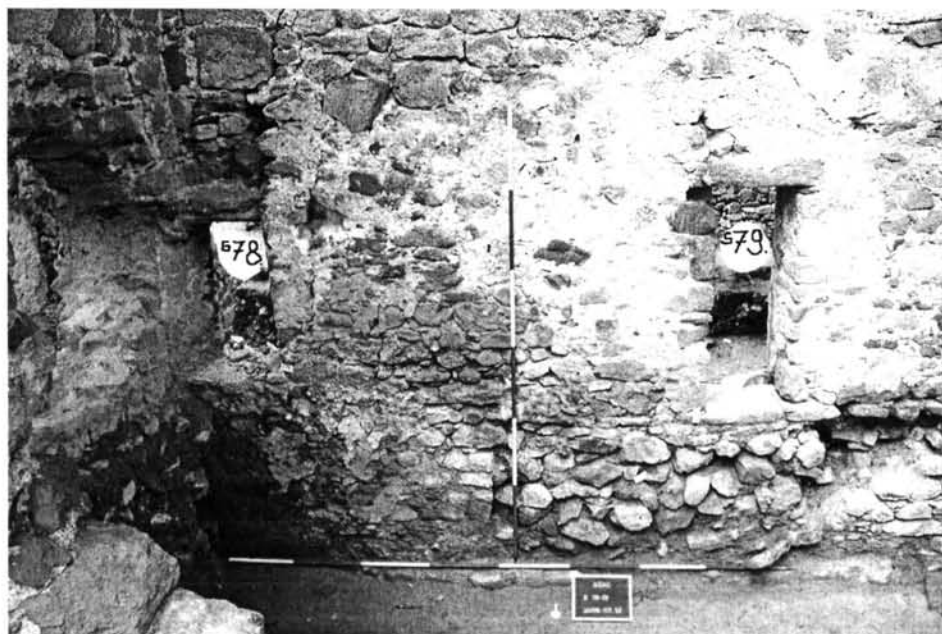
3. kép. A hajó északi falában található s78-, és s79-nyílás
