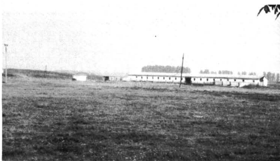
7. kép. A leleszi legelő és az azon épített istállók, 1982. Lelesz
