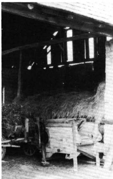
32. kép. Károlyfalva, Rákóczi u. 51. sz. kőből épített csűrbelső
