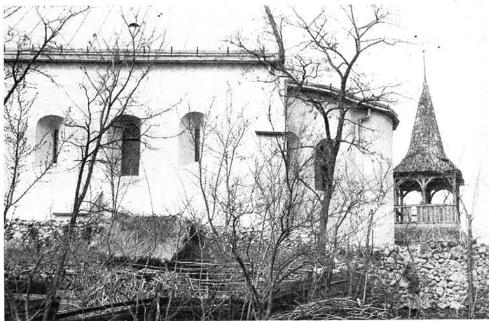
2. kép. Déli homlokzat a helyreállítás előtt
