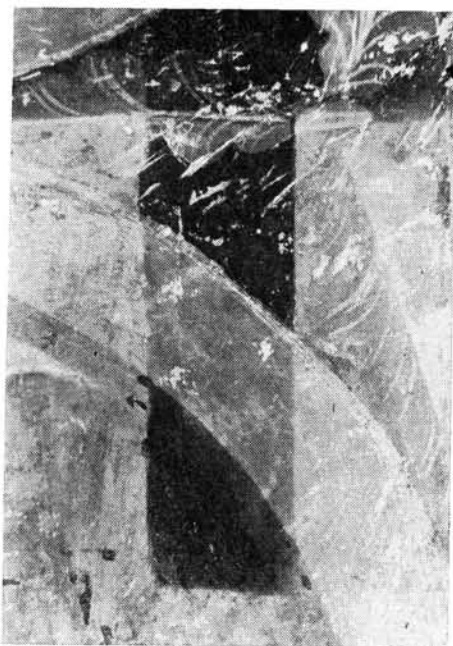
9. kép. Részlet a diadalivról. A sókiválás leoldásának próbája
