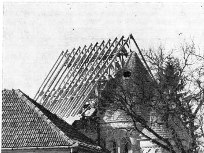
11. kép. Az új tető építés közben
