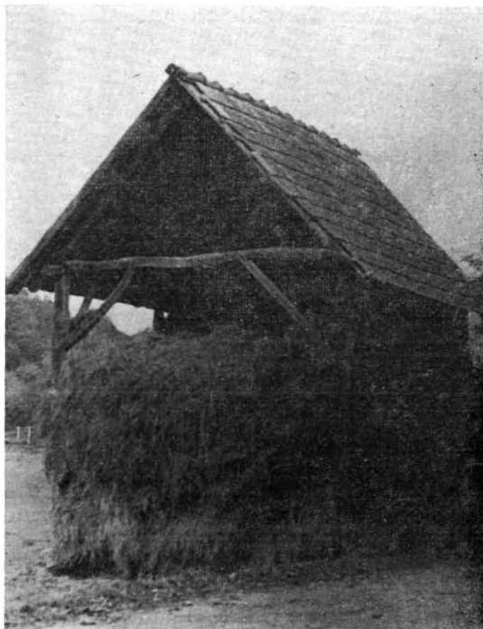
1. kép. Négy oszlopon álló rakodó. Tornakápolna, Paládi-Kovács A. felv. 1969.
