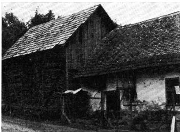
5. kép. Ravásolt, zsilipelt falazatú szénarakodó. Perjése (Dražice), Paládi-Kovács A. felv. 1978.
