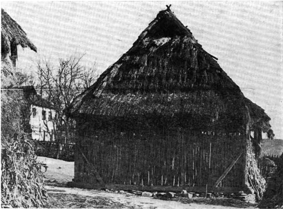
9. kép. Régelyes fal a csűrön. Teresztenye, Borsod m. Selmeczi Kovács Attila felv.
