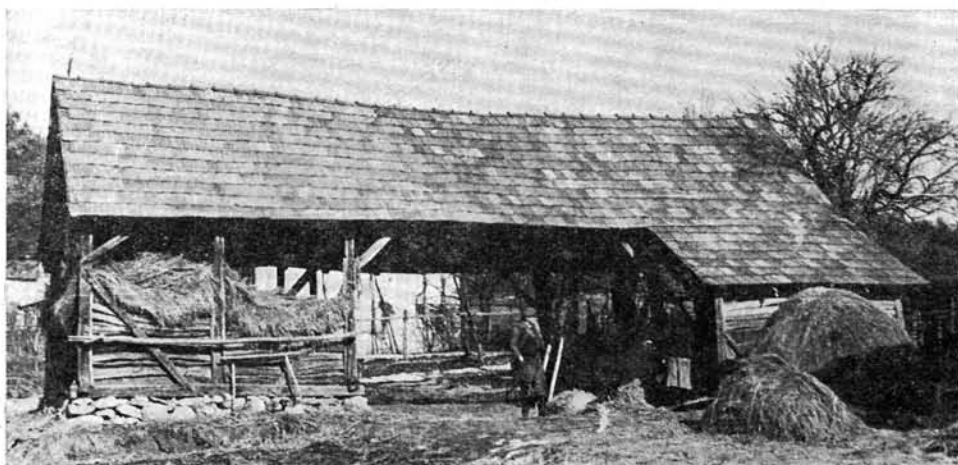
7. kép. Gerendaváz as csűr félíg felrakott ravásfállal. Teresztenye, Borsod m. Selmezi Kovács Attila felv.
