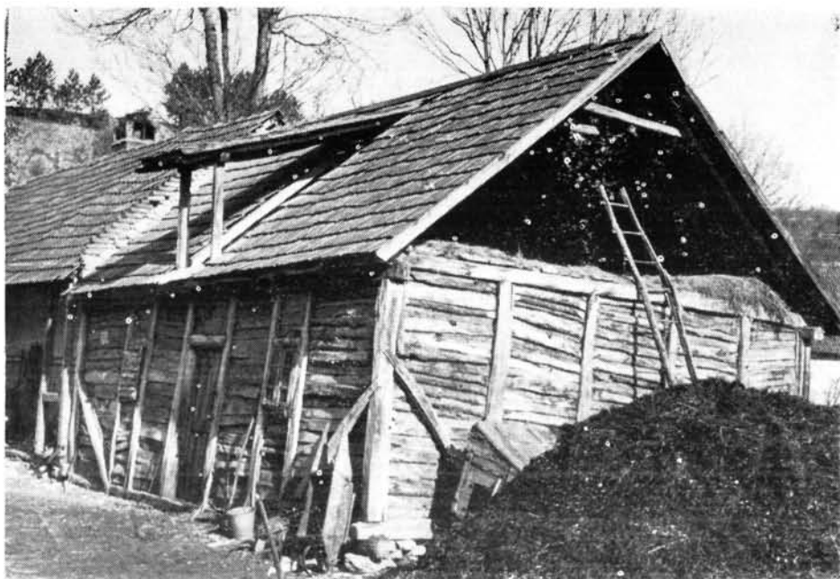
5. kép. Gerendavázás istálló ravásfallal. Jósvafő
