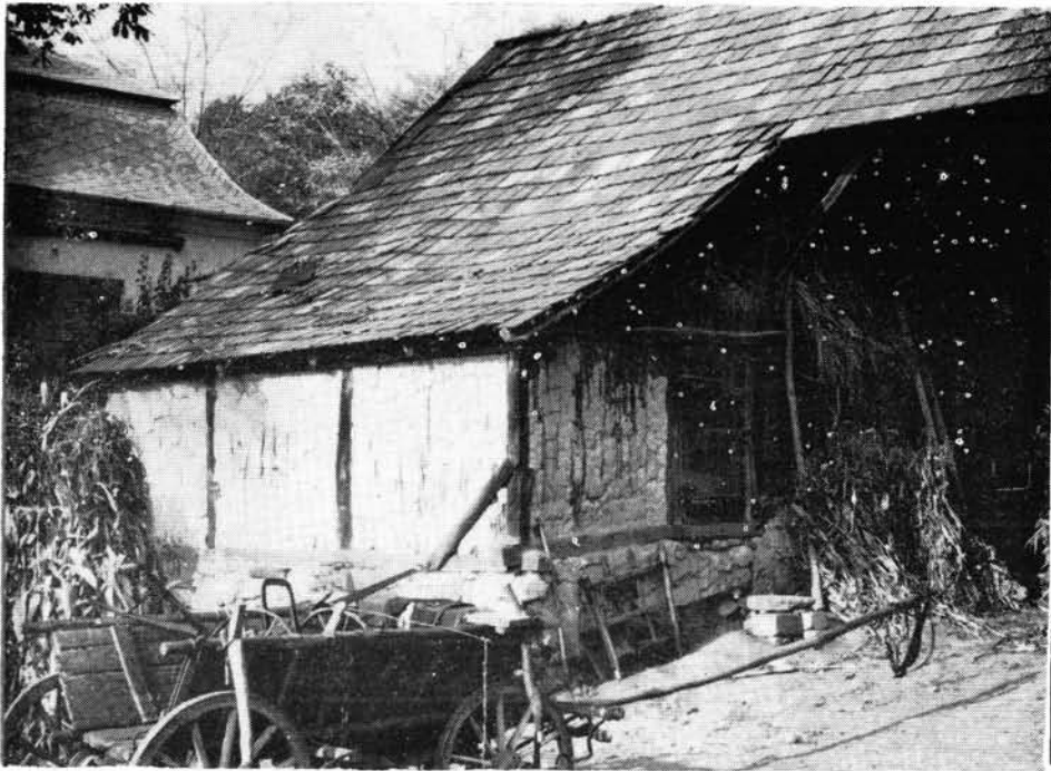
6. kép. Tapasztott régelyes fal gerendavázás csűr toldalékpületén. Borsodbóta
