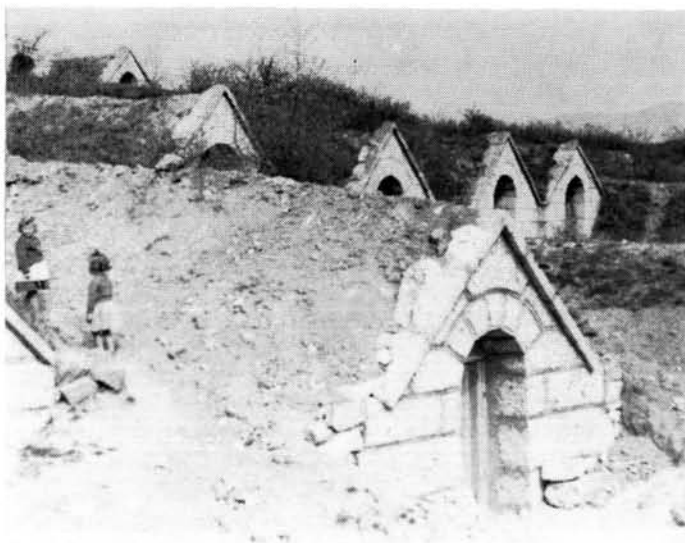
11. kép. Háromlépcsős pincesor a falu alatt. Hercegkút. Balassa I. felv.
