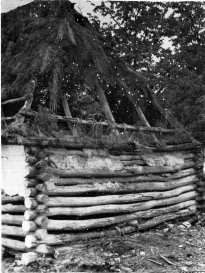
12. kép. A boronaépítkezés technikája. Janó A. felv.
