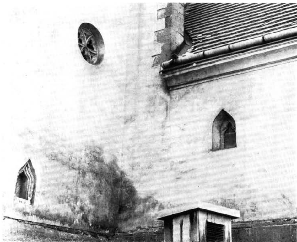
5. kép. A két kápolnát elválasztó gótikus faldarab és mérnöves ablaka. Broczkó T. felv.
