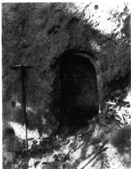
5. kép. Kaptárfülke a csakótanyai csoportból igen jól látható peremkiképzéssel és a fedőlap rögzítését célzó éklyukakkal
