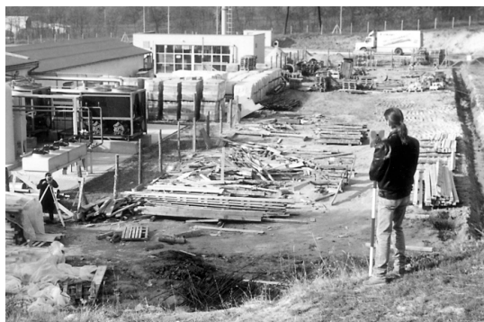
Építés-felügyelet (Fotó: Busics György)
