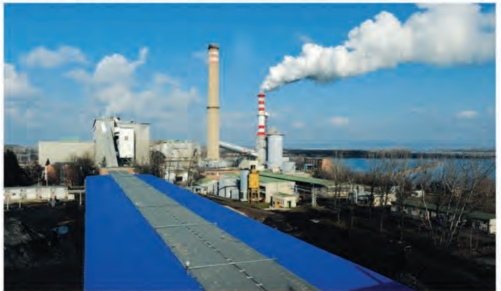
A négy üzemelőblokkal működő Oroszlányi Erőműben két kazánban elégethető biomasszát használnak MTI-FOTÓ – MANEK ATTILA felvétele
