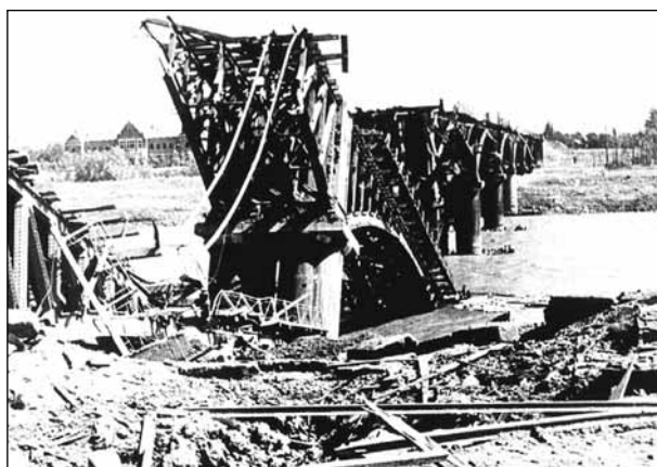
A lebombázott híd
