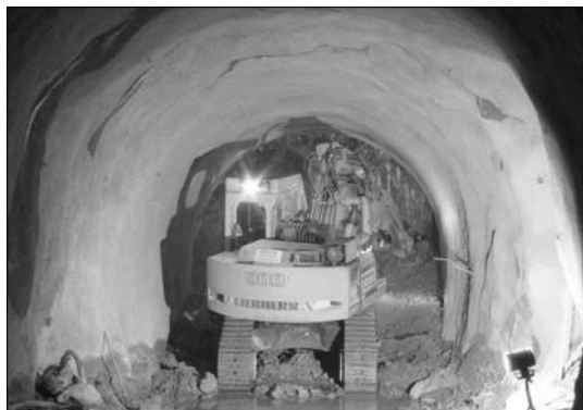
2. ábra Alagúthajtó bagger
