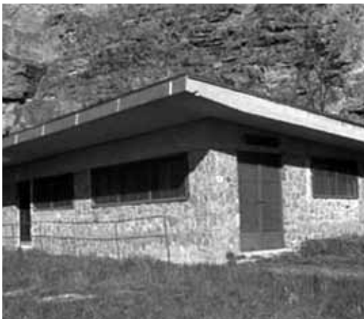
4. ábra A sopronbánfalvi Geodinamikai Obszervatórium épülete
