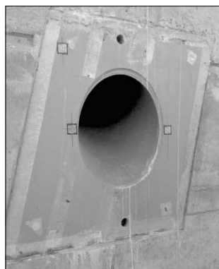
7. ábra Kábel fogadó pont a pilonszáron és a mérő föliák
