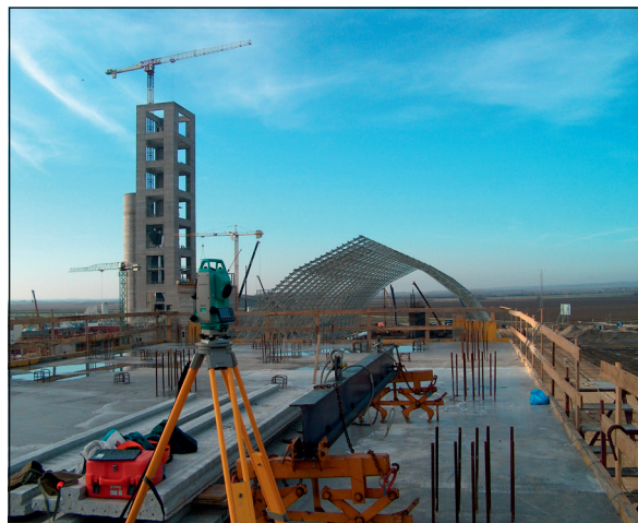
Cementmű építése – Királyegyháza, 2010
