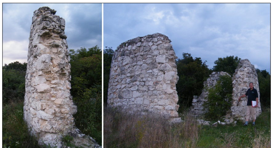
7. ábra. A kerekszenttamási templomrom 2014 augusztusában. A külső fal befelé dől.
