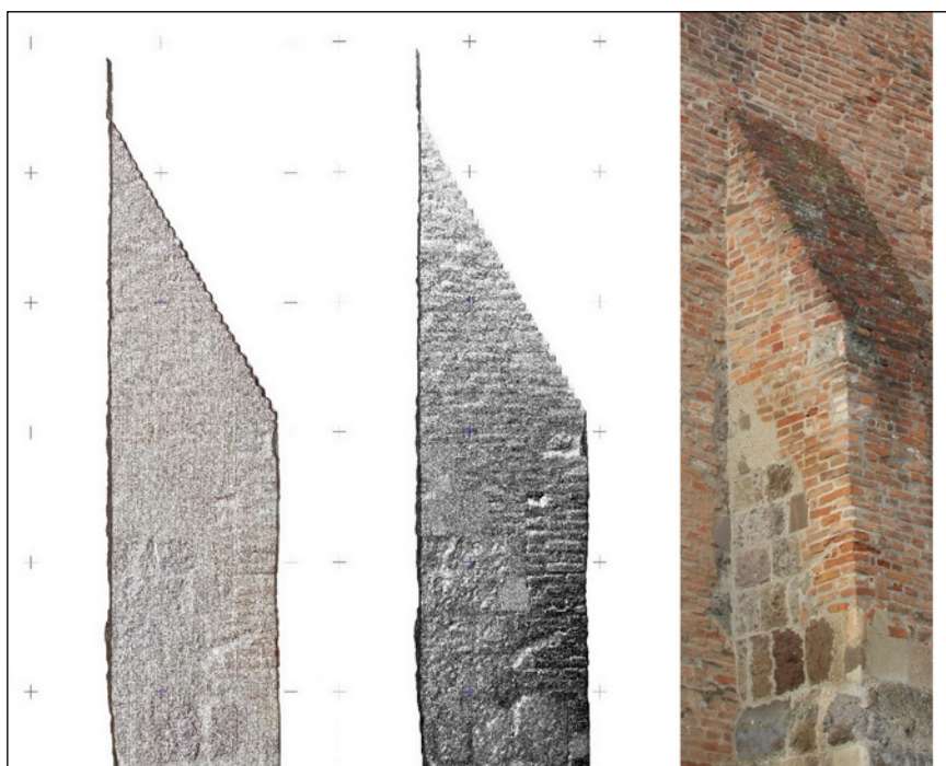
7. ábra. Valódi színes (bal) és intenzitás szerint színezett (középső) pontfelhő, valamint a helyszínen készült dokumentációs fénykép (jobb).
