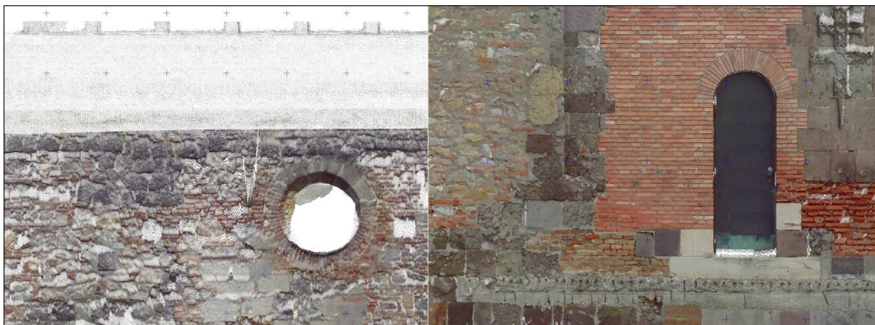
6. ábra. Lézeskennerral és drómmal készített, egyesített, újramintavételezés nélküli pontfelhőből levezetett ortonézeti részlete a vár egy külső, tetőközeli szakaszáról (bal), valamint egy alsóbb szakaszáról (jobb).
