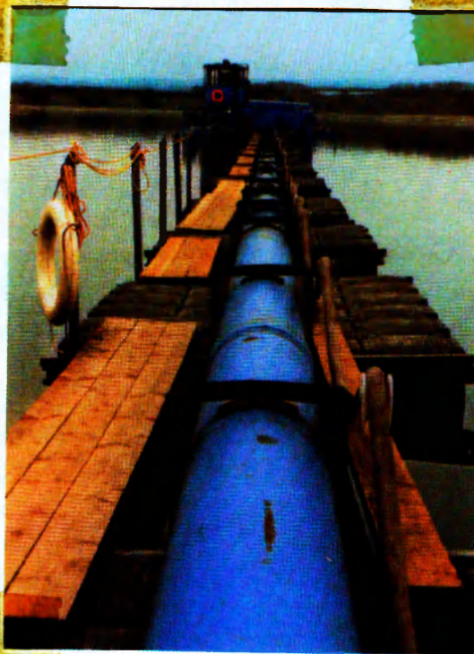
9.számú ábra : JETFLOAT mint úszó aljzat
