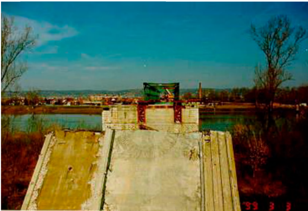
9. ábra: Bontás után a lerombolt híd maradványai
