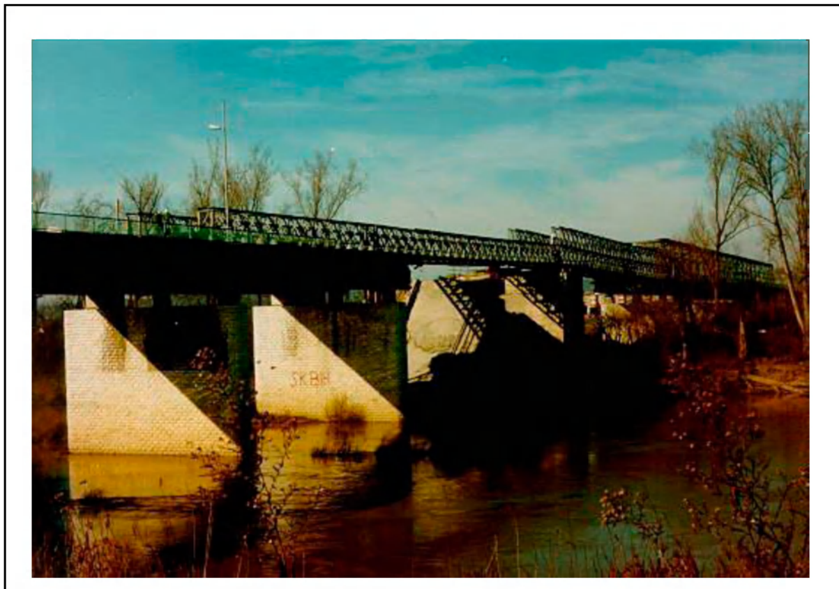
2. ábra: Hídszerkezet a bontás megkezdése előtt
