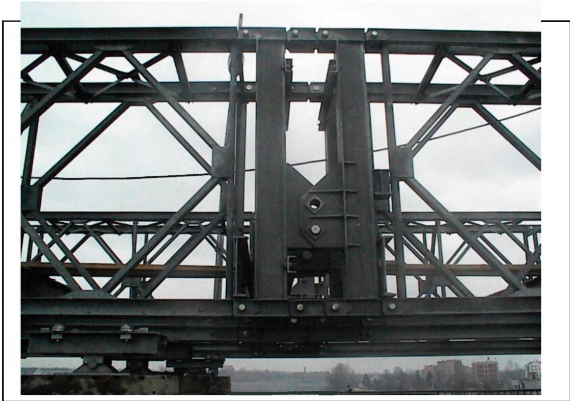
4.ábra: Feszített szerkezet összezáras után
