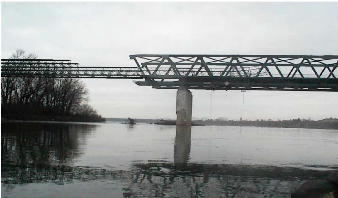
7. ábra: Hídszerkezet kihúzás közben, az orr-résszel
