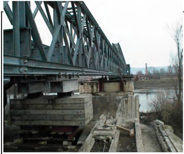
6. ábra: Máglyákra és görgőkre helyezett hídszerkezet
