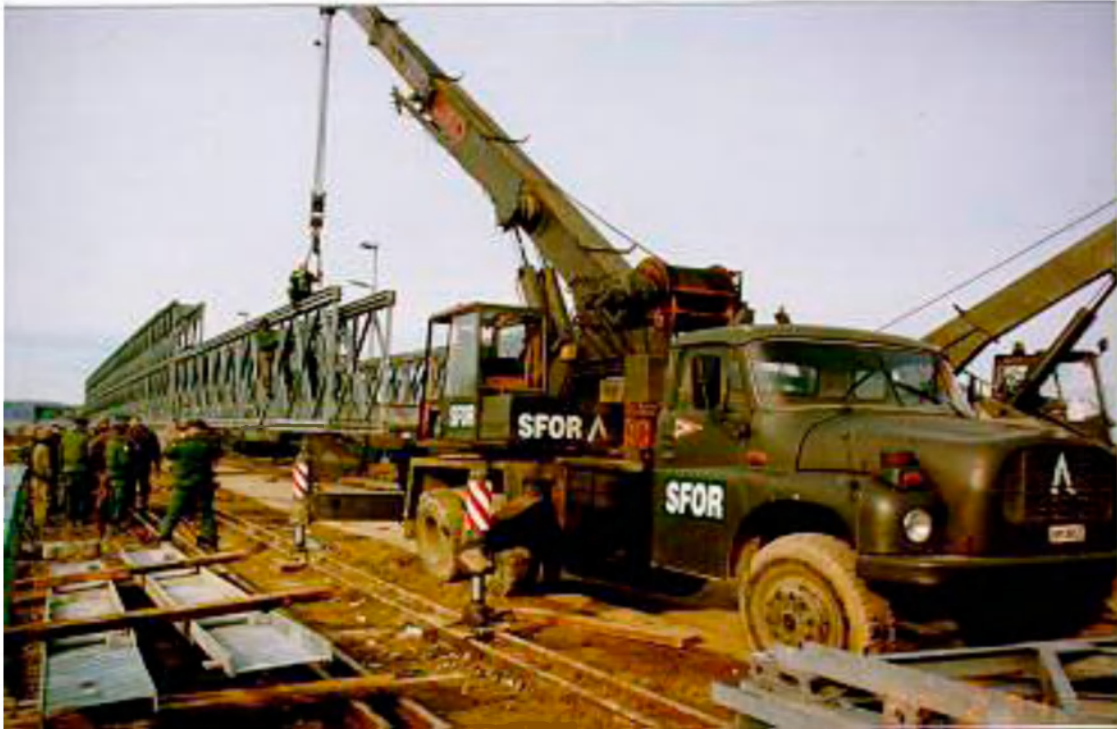
8. ábra: A hídszerkezet szétszerelése
