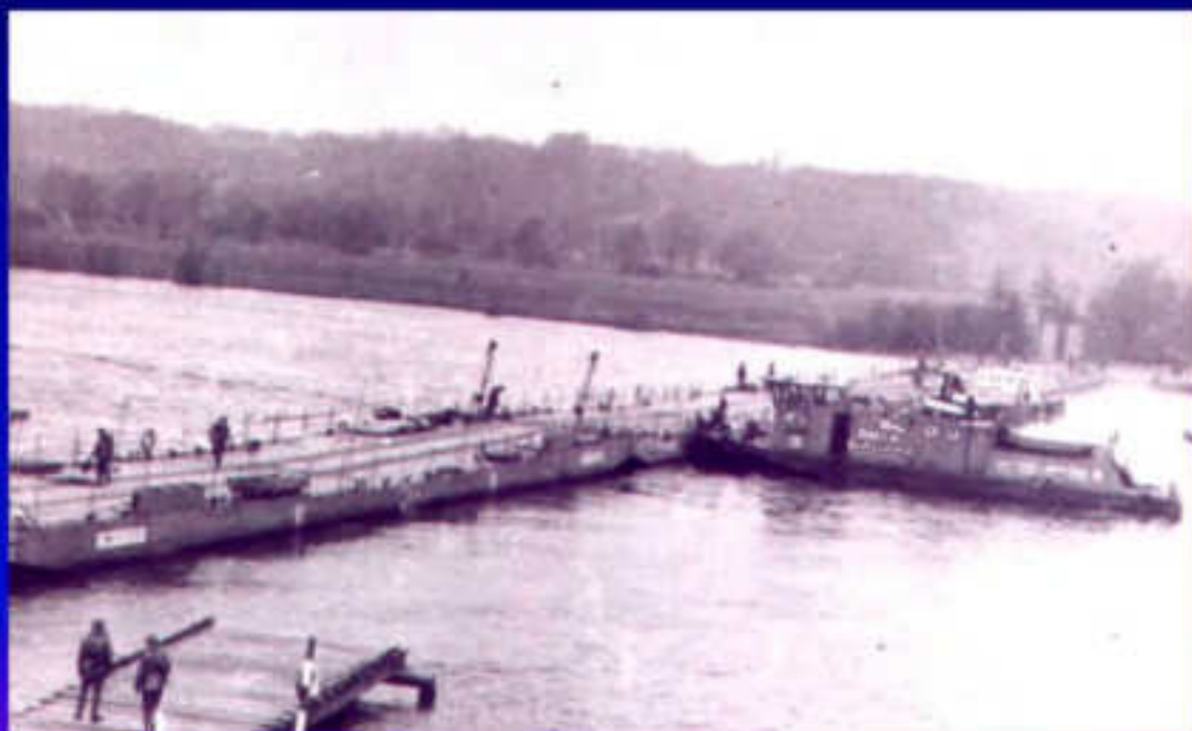
A TS uszályhíd építése a Dunán
