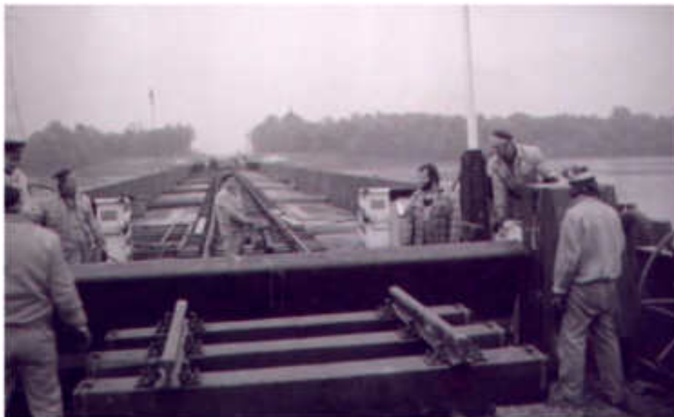
A vasúti pályaszerkezet építése az uszályhiden
