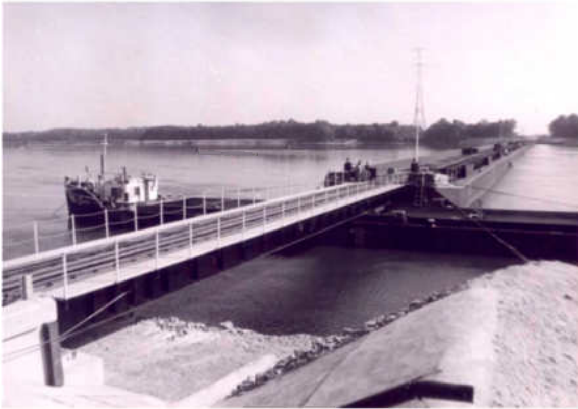
A már beépített vasút feljárási hid és az elkészült uszályhid
