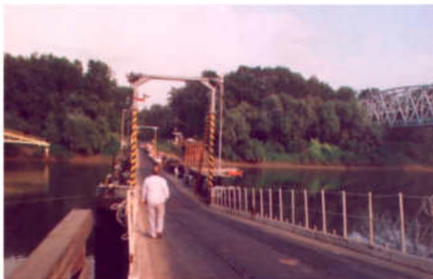
A tokaji Tisza-híd pótlására épített uszályhid II
