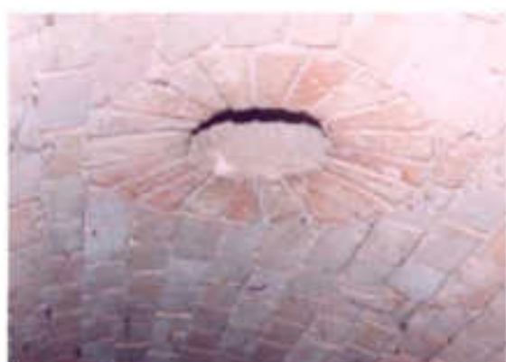
Szellőzőkürtő indítása az áknafüggelék galéria mennyezetén
