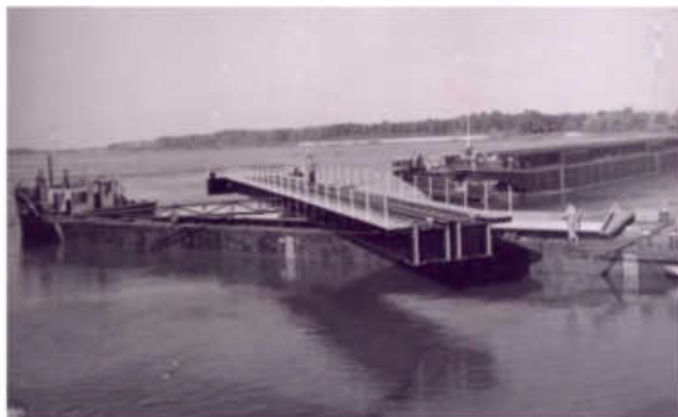
A vasúti feljáróhid beépítése
