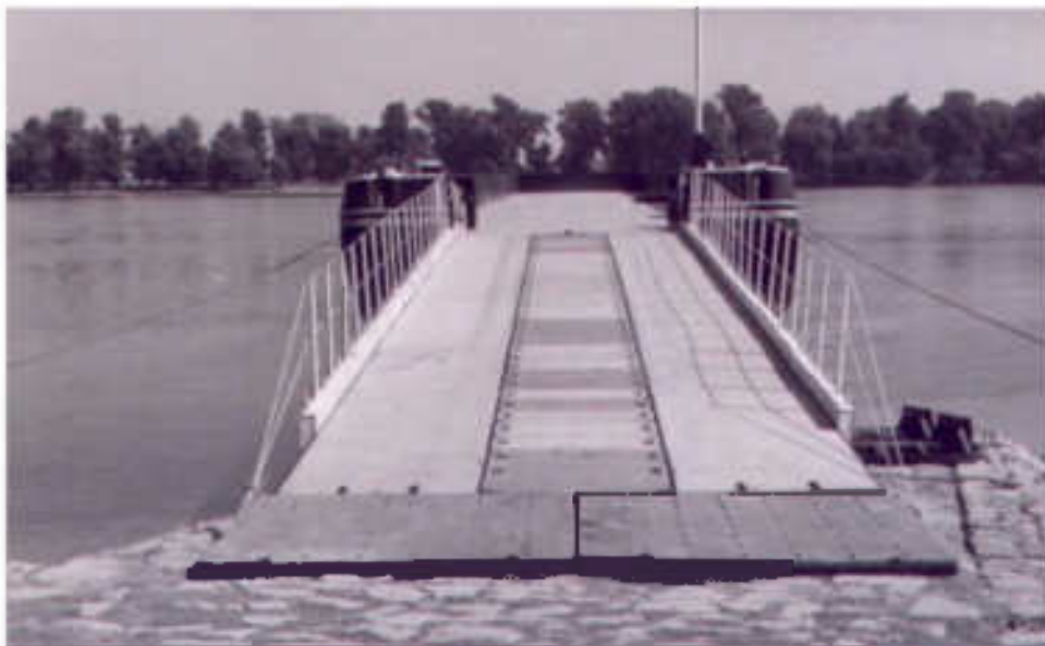
A közúti hídfeljáró, amelyen jól láthatóak a 2 db felhajtást megkönnyítő éktest (előtérben) és a teherbíró lálcák (középen)
