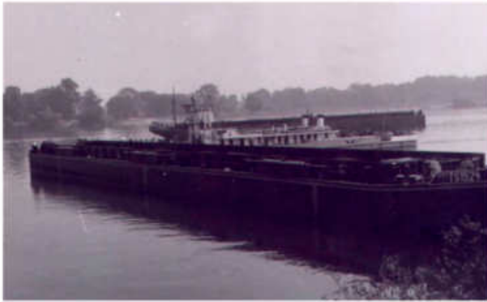
A TŠ-uszályhíd építése I.
