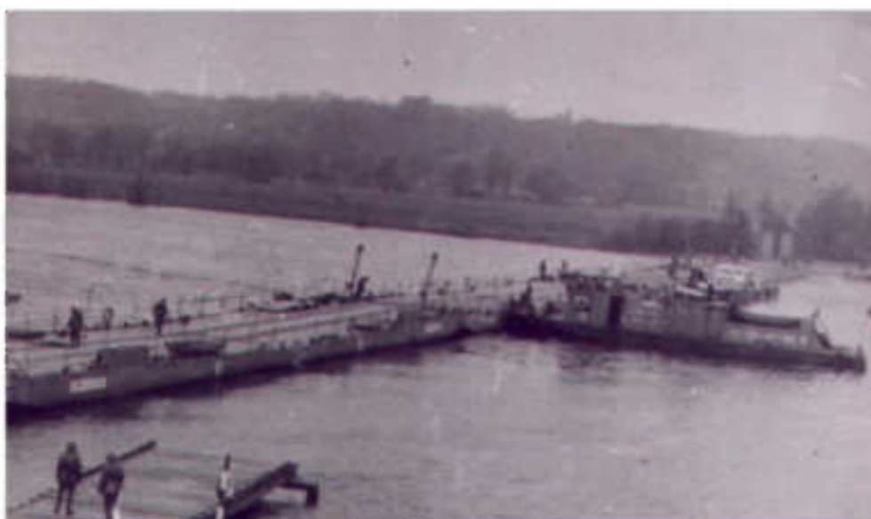
A TS-uszályhid építése II.
