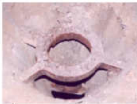
Árnyékszék ülőke tartószervezete a Tüzérbástyában
