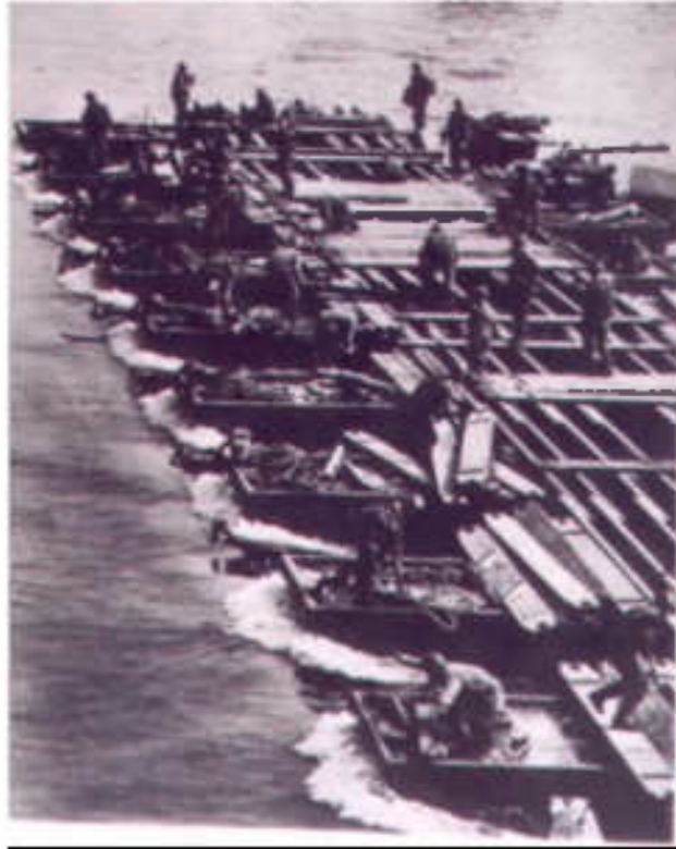
szovjet pontonhíd építése
