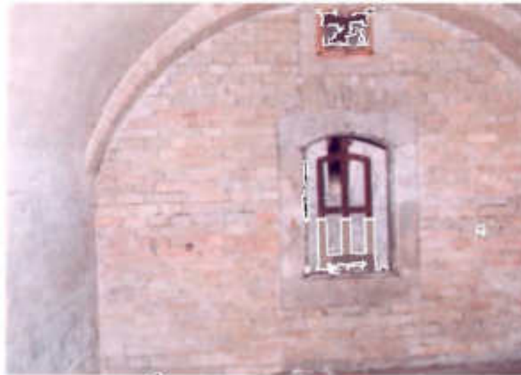
Ágyfűtőbrés a szellőzővel
