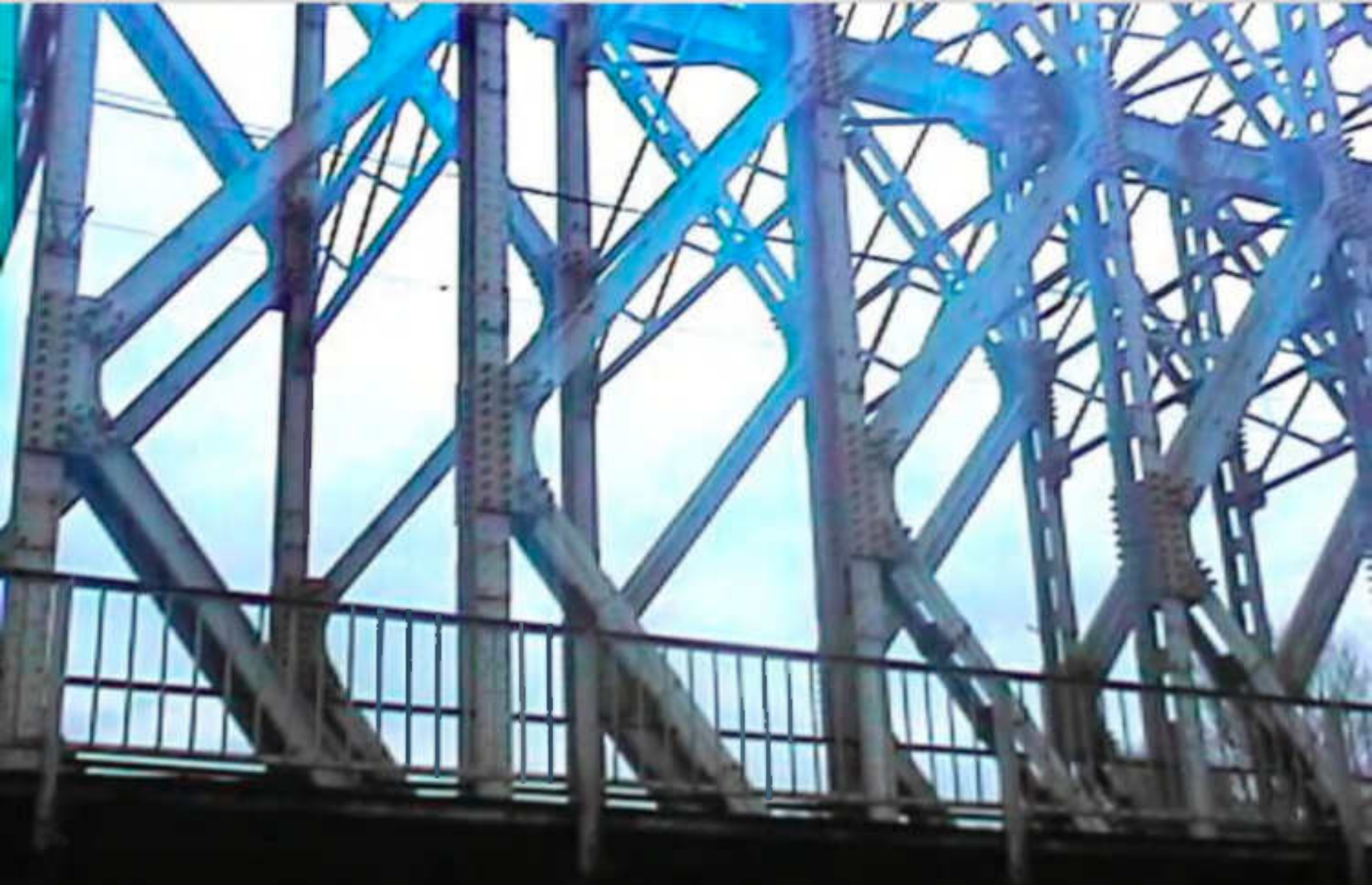
A kéteemeletes jellegzetes „K” mintázatú rácsszerkezet
