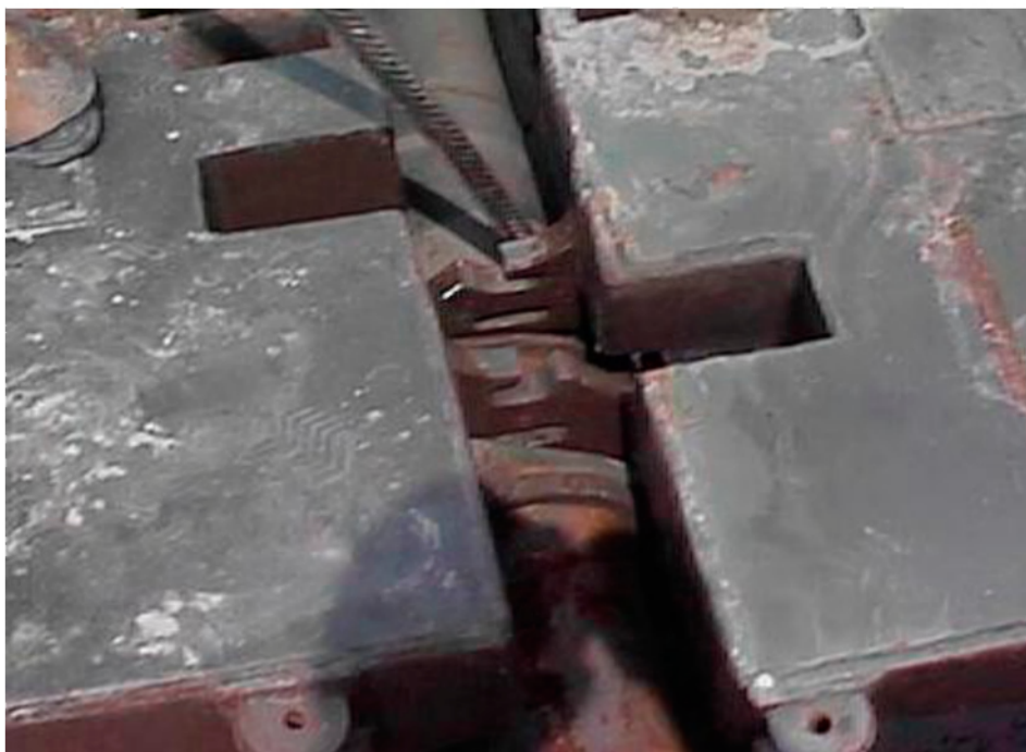
3. Ábra: A hídfedélzetek feltámaszkodása a fejgerendára
