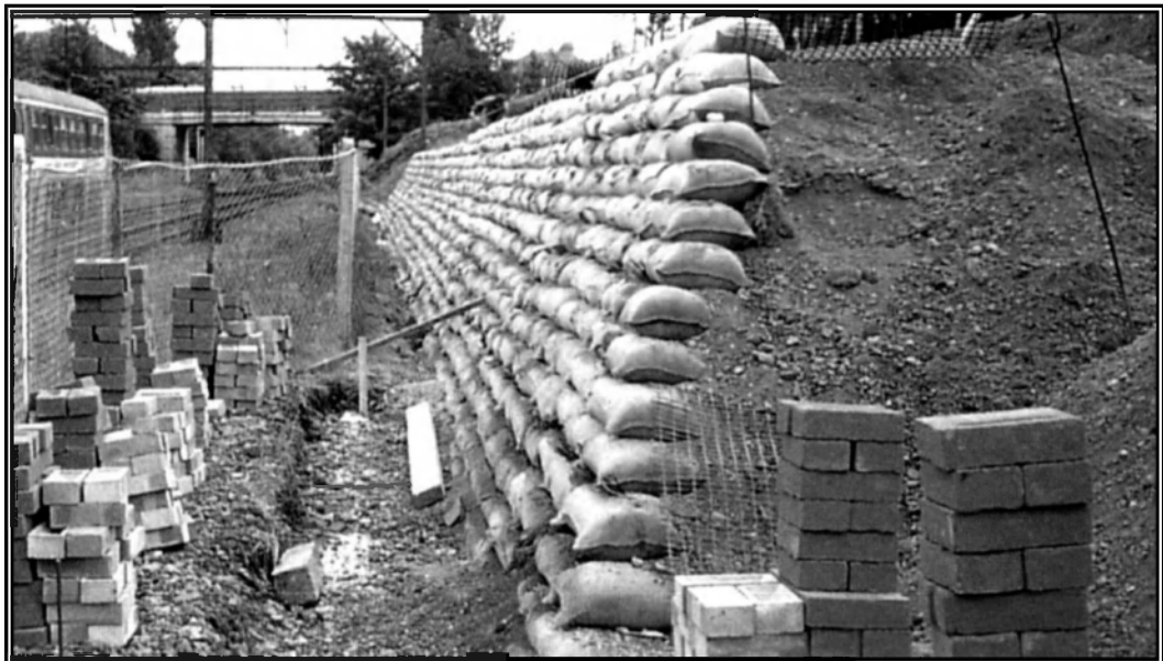
12. ábra: Talajjal töltött zsák homlokfelületű védőfal
