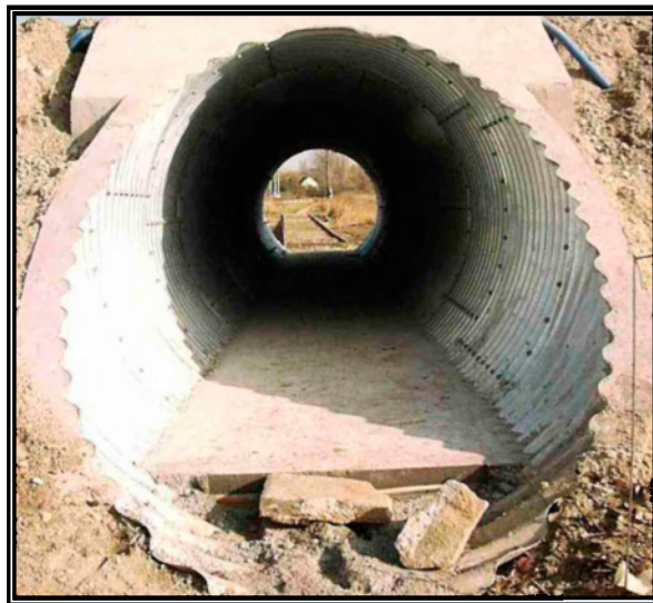
2. ábra: HAMCO hullámlemez áteresz 20
