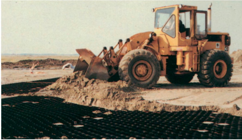
12. ábra: Geocellák beépítése
