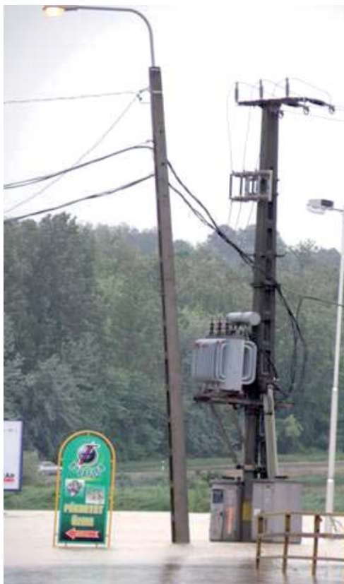
Vízben álló villanyoszlop transzformátorral
