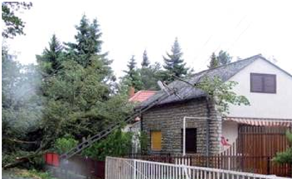
Villanyoszlop dőlt családi házra
