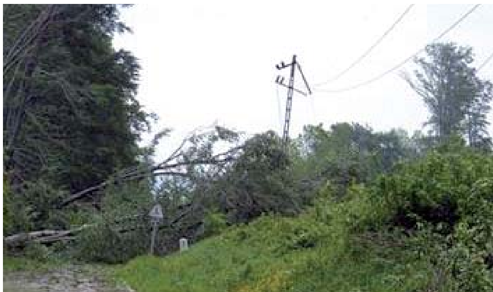
Távvezetékre dőlt fa, mely megszakította az ellátást
