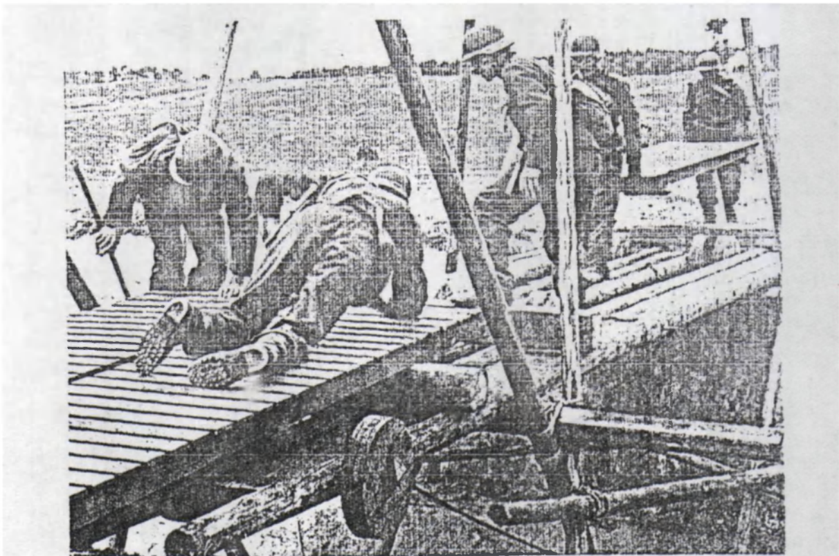
Átkelőhely építése harckocsiárkon a rohamosztagot követő gyalogság nehézfegyverei számára. Az építmény alapját két egymás mellé helyezett kerek vetőbürü képezi.
