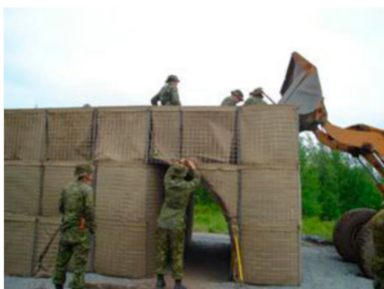
Az elkészült RAM típusú óvóhely 29
