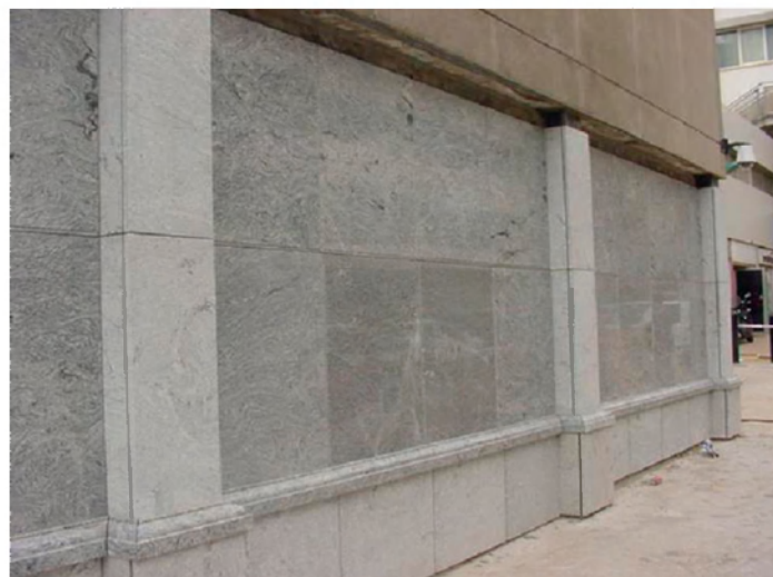
4. ábra: A megerősített oszlopok végső megjelenésükben, semmiben sem különböznek a normál szerkezetektől
