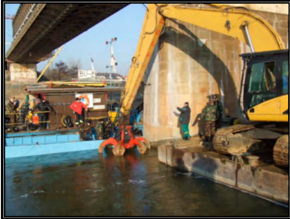
6. ábra: Kotrógép a hídpillér mellett 7
