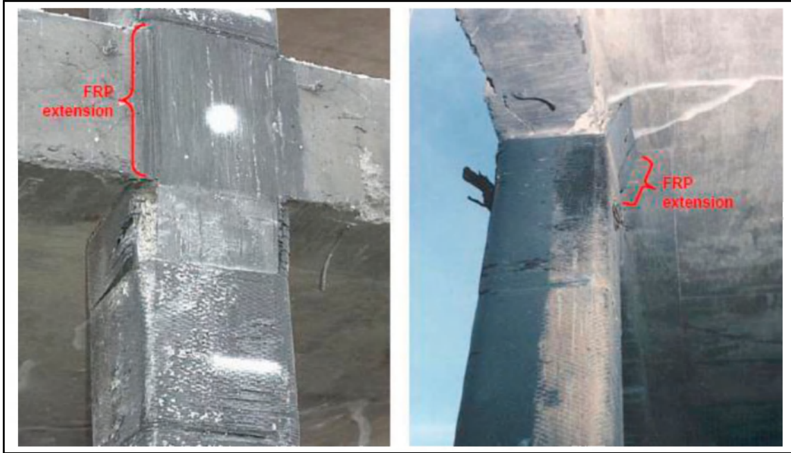
3. ábra: Erősítőcsíkok túlnyújtása
