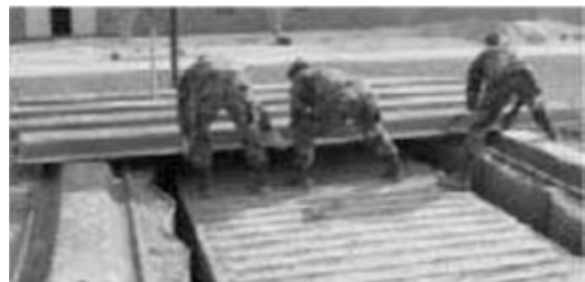
Fokozott védelemmel rendelkező óvóhely földemének beépítése 32
