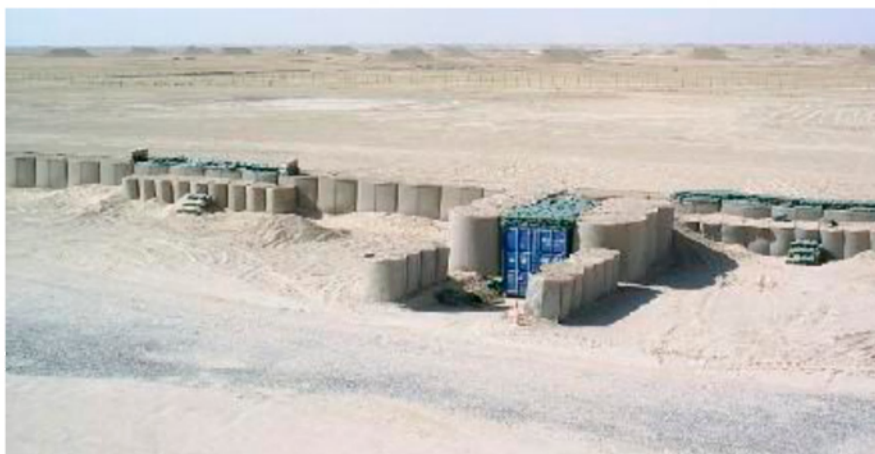
Anyagok tárolására berendezett konténer óvóhely 27
