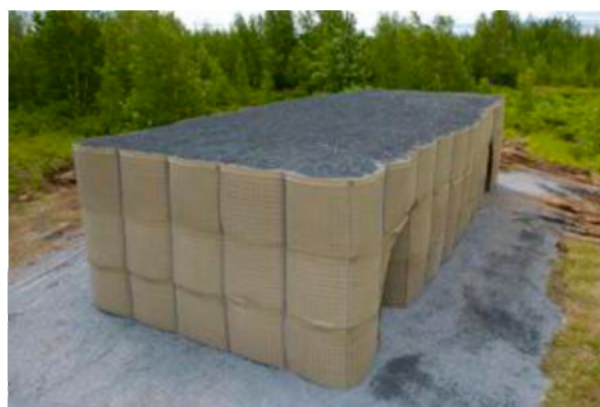
Az elkészült RAM típusú óvóhely 29
