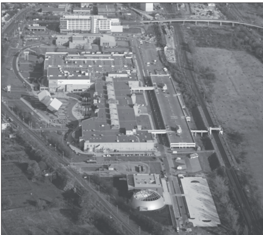
2. kép. Campona Rendezvényközpont, Campona Szórakoztató- és Bevásárlóközpont és parkolóház, Művelődési-ház, művészeti iskola és tanuszoda, MCC Médiaközpont
