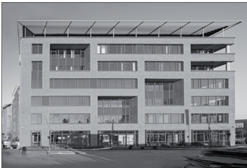
3. kép. Az Infopark „D” épülete,
