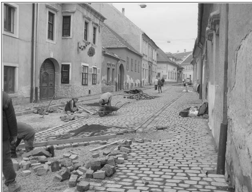
4. ábra. Kockakő burkolat építése a Balfi utcában 2007 decemberében
