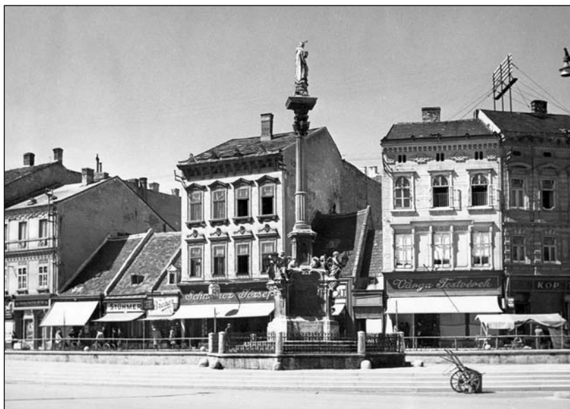
1. kép. A Várkerület belső ívén sorakozó épületek és üzletek 1936 körül (Fotó: Diebold Károly) Forster Gyula Nemzeti Örökségvédelmi és Vagyongazdálkodási Központ Fotótára
