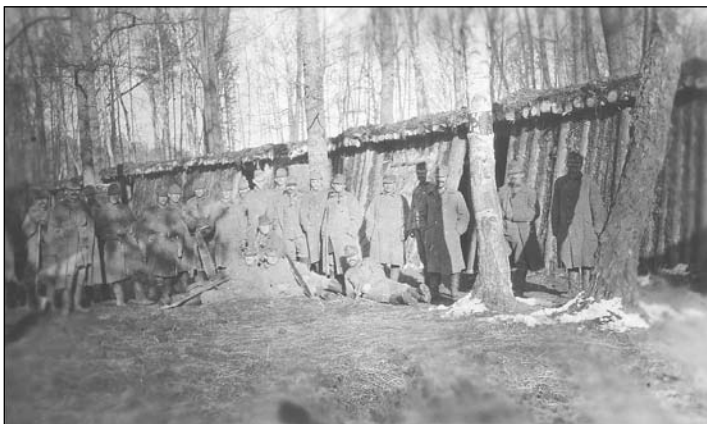
3-4. kép. Fedezékek, istállók építése (3., 5.)
