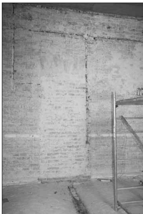
5. kép. Építéskori szintjelölés az F10 helyiségben, az egykori ajtó helyén, melyet 1913-ban befalaztak, ezen a szintjelölés hiányzik. Nemes András fotója, 2018.
