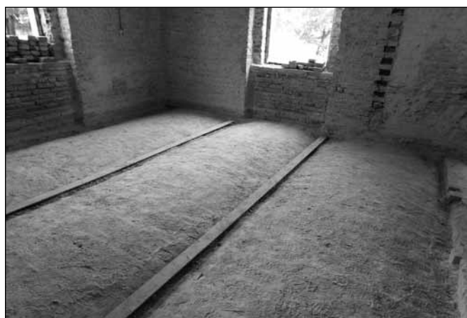
2. kép. A pincefödémek boltozottak, illetve poroszsüveg boltozattal készültek, ezek állapota jó, itt nem készült megerősítés.
