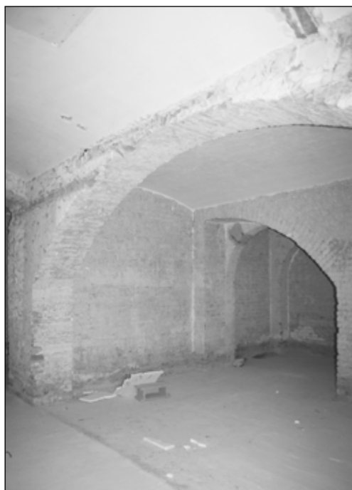
4. kép. Az egykori tüzelőraktár, majd borospince (P03) fala ideiglenesen visszabontva az 1890-es állapotra. Nemes András fotója, 2018.
