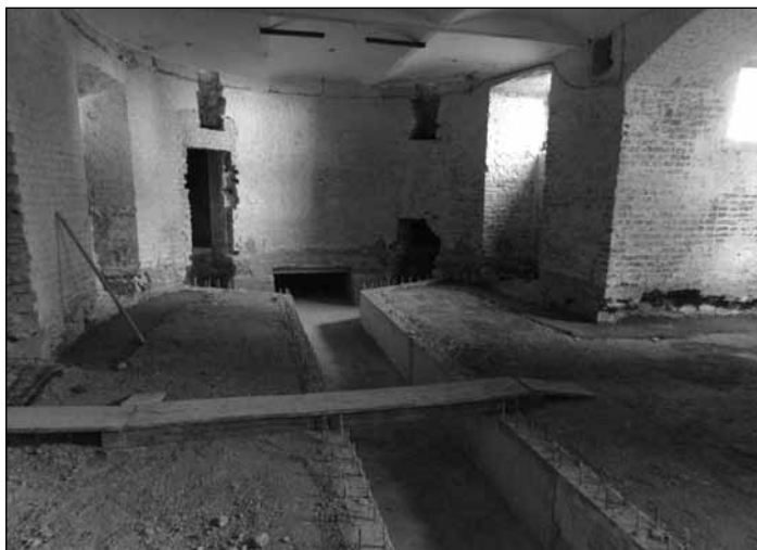
4. kép. Készülő légcsatorna aknák a konyha padlója alatt
