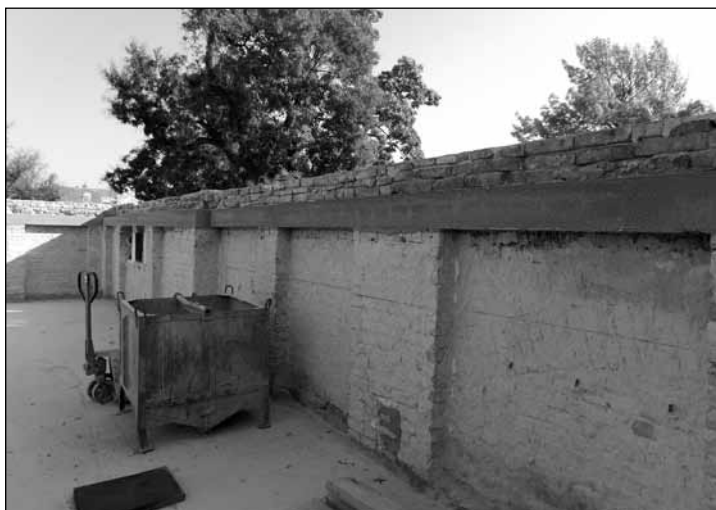
6. kép. A fedélszéket fogadó koszorú már elkészült.
