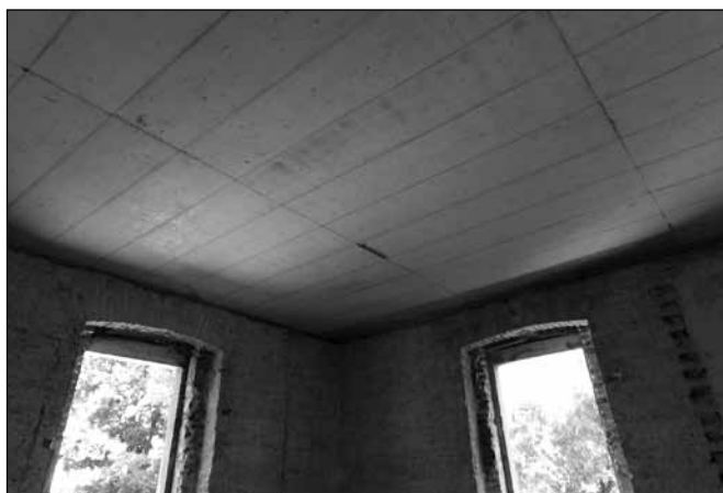
1. kép. Új vasbeton födém
