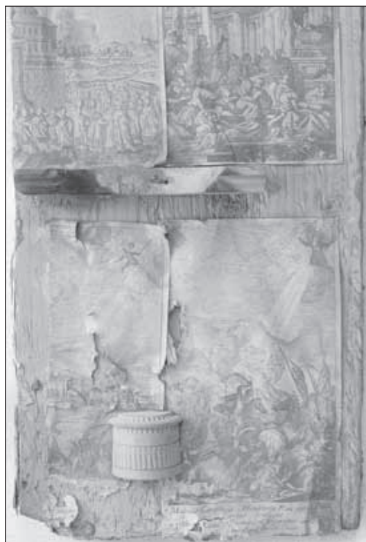
7. kép. Sérült, hiányos papír nyomtatványok a belső falon. (A szerző felvétele)
