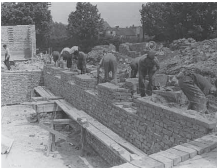
4. kép. A KISZ-ház falazása. A felvételt Kubinszky Mihály készítette (SOE KL).
