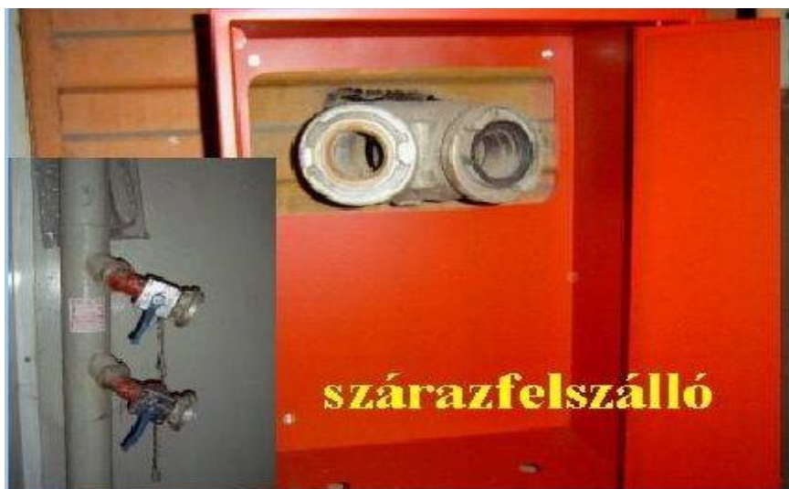
1. számú kép. Száraz felszálló. Készítette: Mazák Viktor 2010
